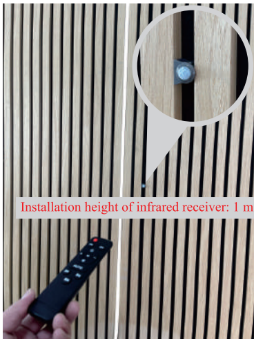
8.Монтирайте приемника за дистанционното управление на височина 100 см над пода.
